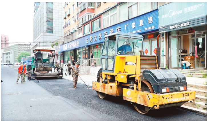
施工人员在维修背街小巷的破损路面。
