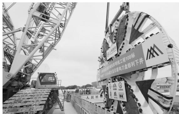
9月12日,在位于上海长兴岛的轨道交通崇明线108标施工现场,重达308吨的“申通号”盾构机刀盘吊装下井作业顺利完成。“申通号”盾构机总长148米,将完成崇明线南越江段全长7.74千米的区间隧道掘进施工,这也将是上海轨道交通穿越长江的第一条隧道。图为一台履带式吊机在进行“申通号”盾构机刀盘吊装下井作业施工。
