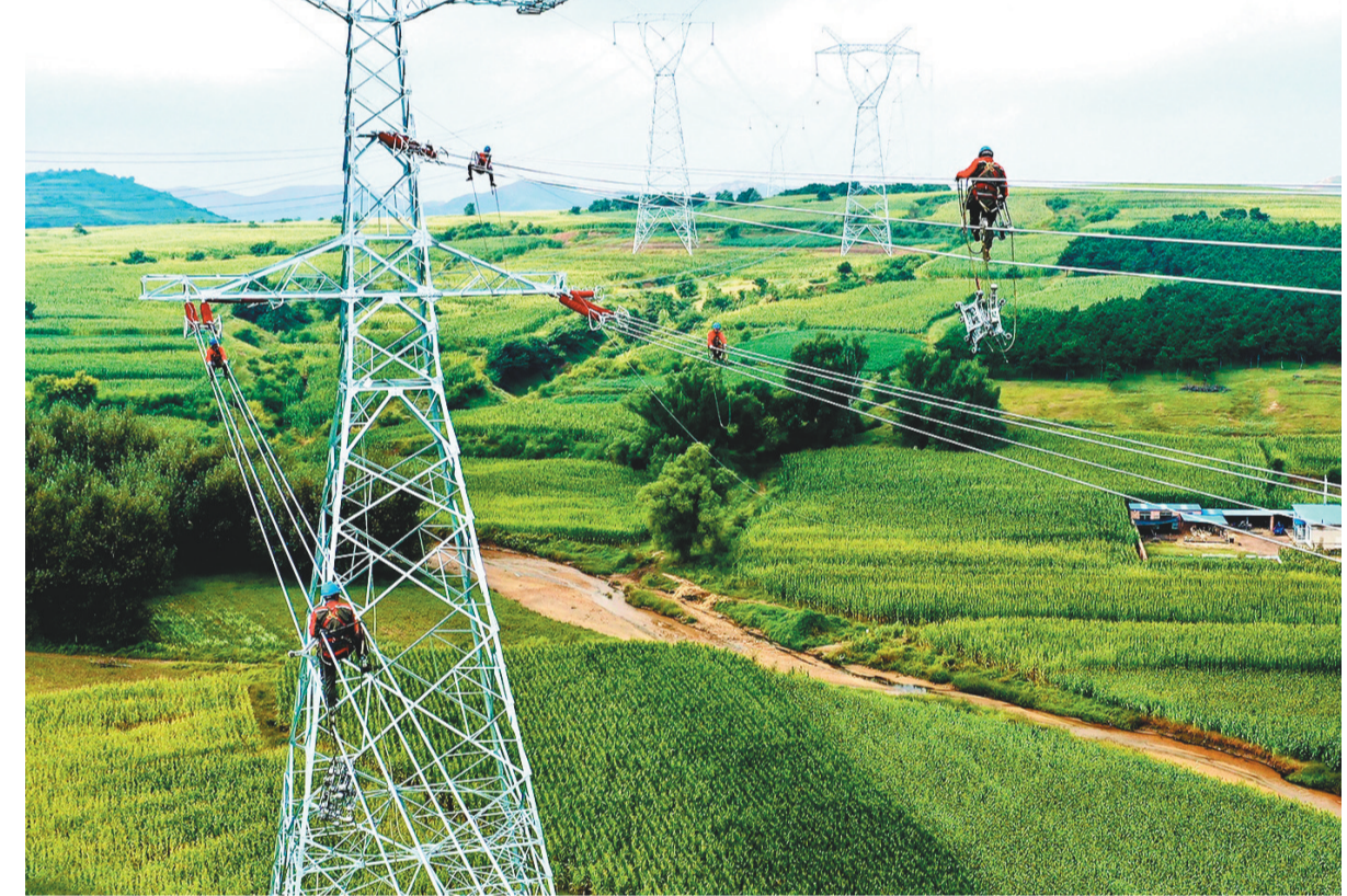
500千伏朝阳川州—阜新输电线路工程施工现场,工人们如高空舞者,在主干路上加紧进行间隔棒安装作业。
