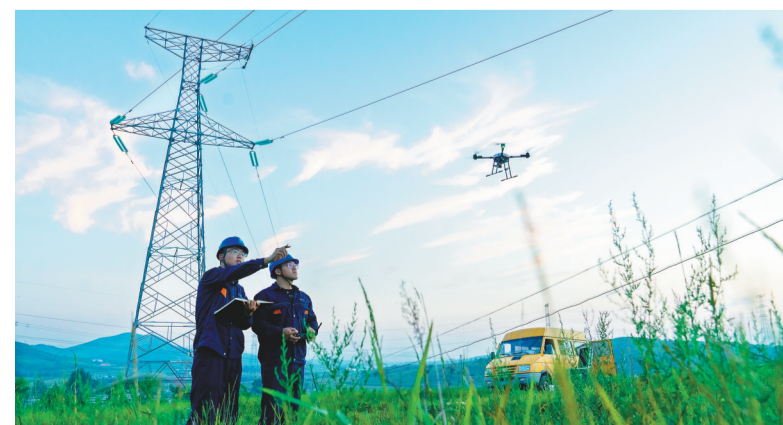
国网营口供电公司供电员工应用无人机对66千伏渤海线进行特巡，准确掌握输电线路运行情况，及时排查用电设备和线路隐患，保障电网安全稳定运行。
