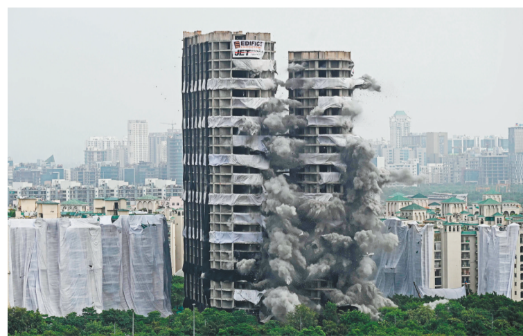
这是8月28日在印度新德里附近诺伊达地区拍摄的“双子塔”爆破现场。28日,坐落于印度新德里附近诺伊达地区的约100米高建筑“双子塔”经爆破拆除。据外媒报道,此次爆破使用了约3700公斤炸药。 新华社发
