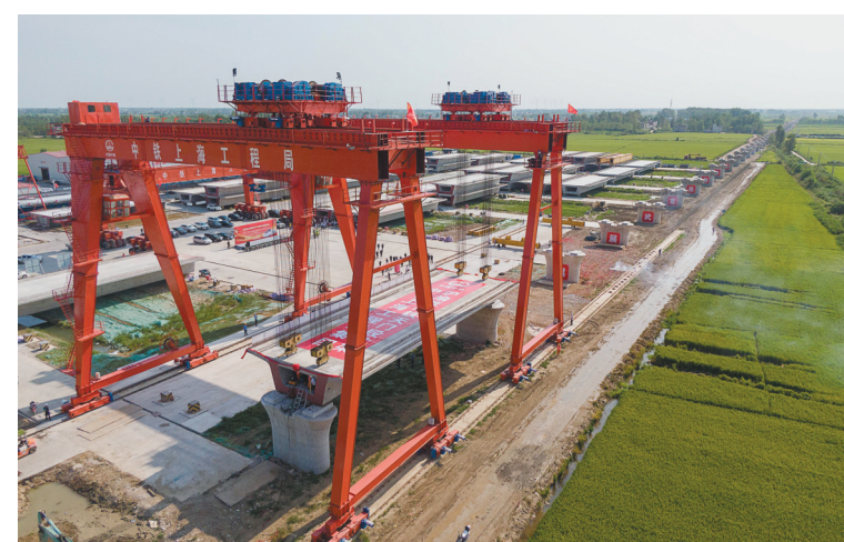
8月25日拍摄的沪渝蓉高铁天门段首榀箱梁架设现场。当日,由中铁上海工程局承建的沪渝蓉高铁天门段首榀箱梁成功架设。据介绍,沪渝蓉高铁武汉至宜昌段位于湖北省境内,是我国“八纵八横”高速铁路主通道之沿江通道的重要组成部分。 新华社记者 熊琦 摄
