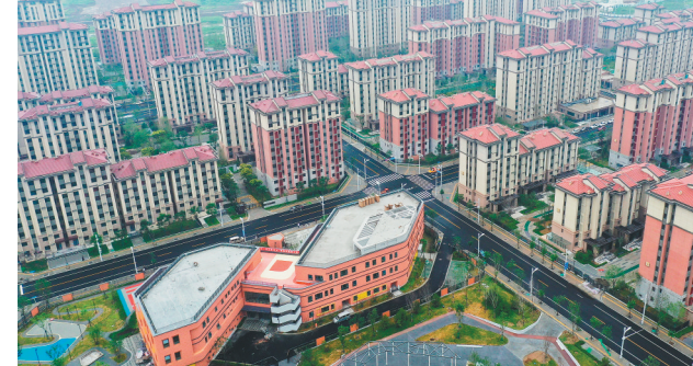
这是雄安新区雄东片区A单元安置房及配套设施项目(8月18日摄,无人机照片)。河北雄安新区雄东片区是雄安新区东片区之后实施回迁安置的第二个新建回迁片区。先期建设的雄东片区A单元11427套安置房将于8月底迎来首批回迁居民。 新华社记者 朱旭东 摄
