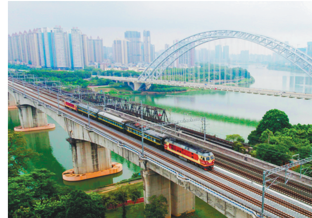
8月18日,联调联试综合检测车驶过永和大桥旁的南崇铁路线。当日,综合检测列车从南宁站驶出开往崇左,对南崇铁路进行首趟联调联试。南崇铁路东起南宁站,经吴圩机场、扶绥县至崇左市,运营里程119.294公里,设计时速250公里。 新华社记者 张爱林 摄
