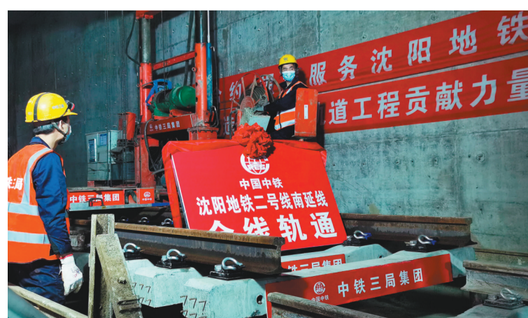
沈阳地铁二号线南延线全线顺利实现“轨通”。 本报记者 高华庚 摄
