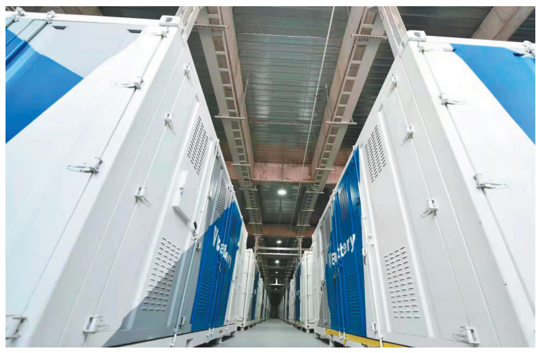
大连高新区企业为全球最大液流电池储能电站提供的自主研发电池系统。
