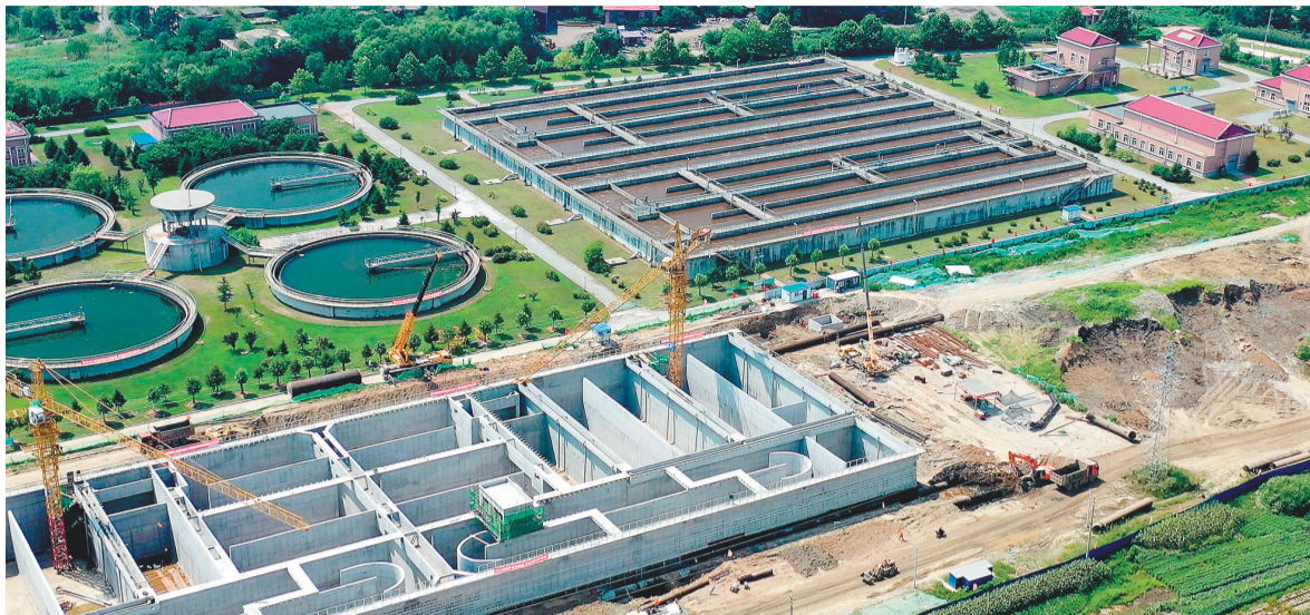
丹东市污水处理厂二期工程项目蓄水池工程。
