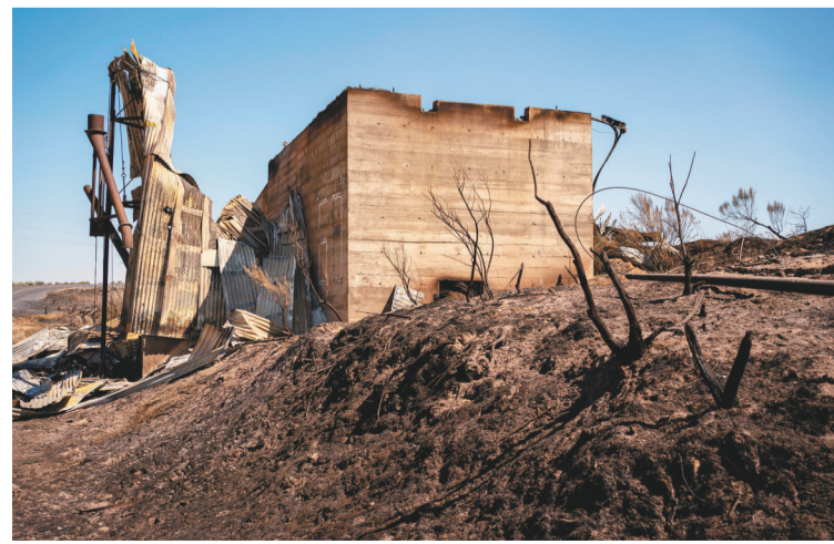
近日,美国西北部经历热浪,高温和大风加剧了野火风险。图为8月5日在美国华盛顿州林德拍摄的野火中被烧毁的建筑。新华社发
