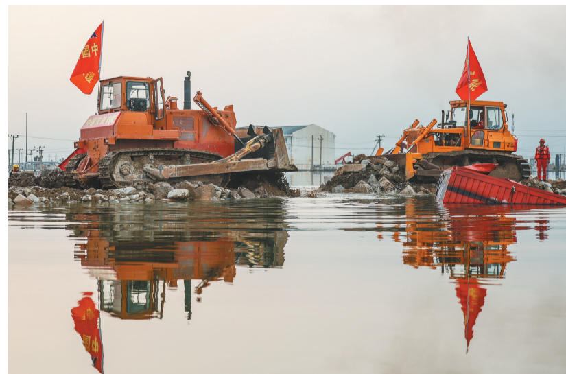
经现场抢险人员连续5天奋战,绕阳河溃口封堵完成合龙。至此,发生在盘锦市域内的绕阳河左岸曙四联段堤溃口抢险取得重大进展。图为8月6日,抢险人员在溃口处进行封堵作业。
