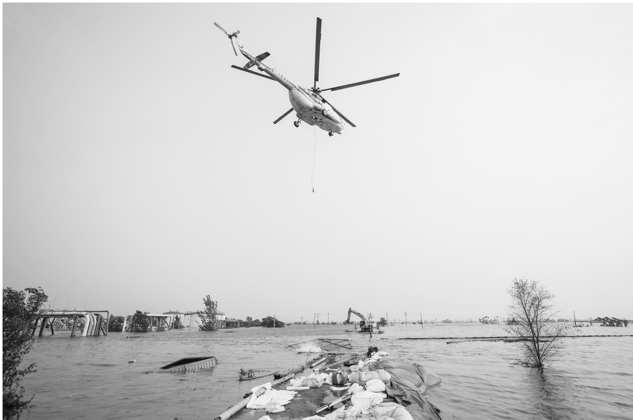
8月4日,盘锦市绕阳河段溃口进行直升机吊装投放六角沉箱作业。
