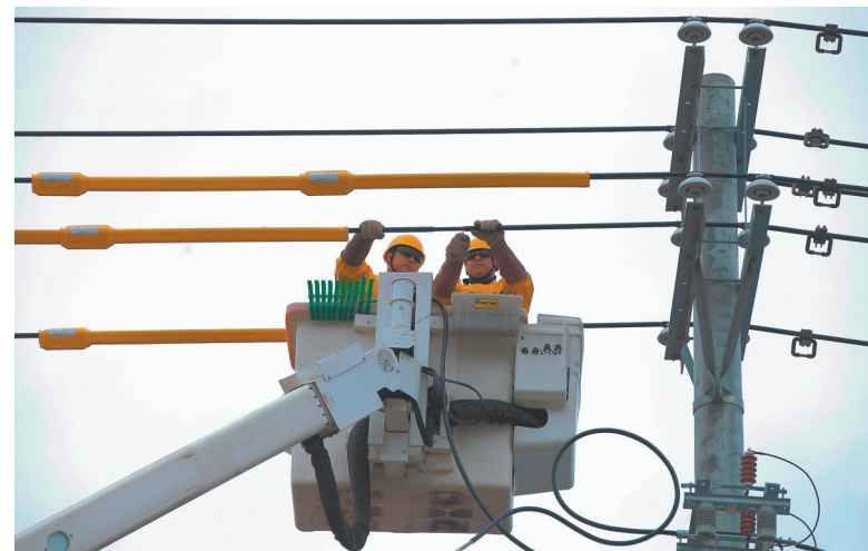
国网朝阳凌源市供电公司员工在三十家子镇华实板厂供电线路上进行带电接引作业,确保夏季用电高峰期间安全可靠供电。 马志远 摄
