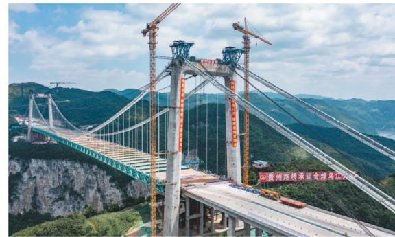
7月10日拍摄的金烽乌江大桥合龙现场(无人机照片)。当日上午,随着最后一块钢桁梁吊装到位,由贵州路桥集团承建的金烽乌江大桥顺利合龙。金烽乌江大桥是贵阳金沙至古蔺(黄金古)高速公路项目的重要控制性工程,全长1473.5米,大桥的合龙为黄金古高速公路明年通车打下了坚实基础。
