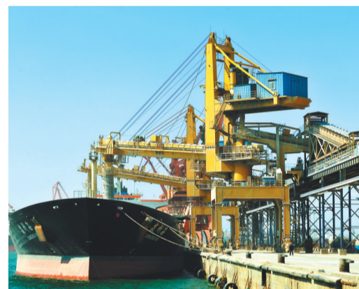
锦州港散粮专用泊位上,正在进行粮食装船作业。
