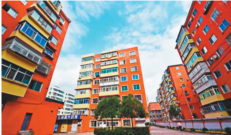
改造后的新闻小区整洁美丽。
