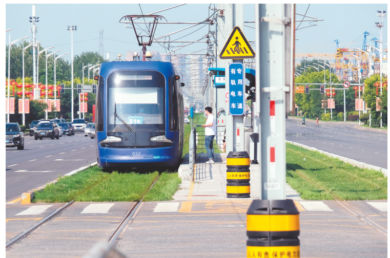
沈抚有轨电车西延线工程为当地居民出行带来便利。
