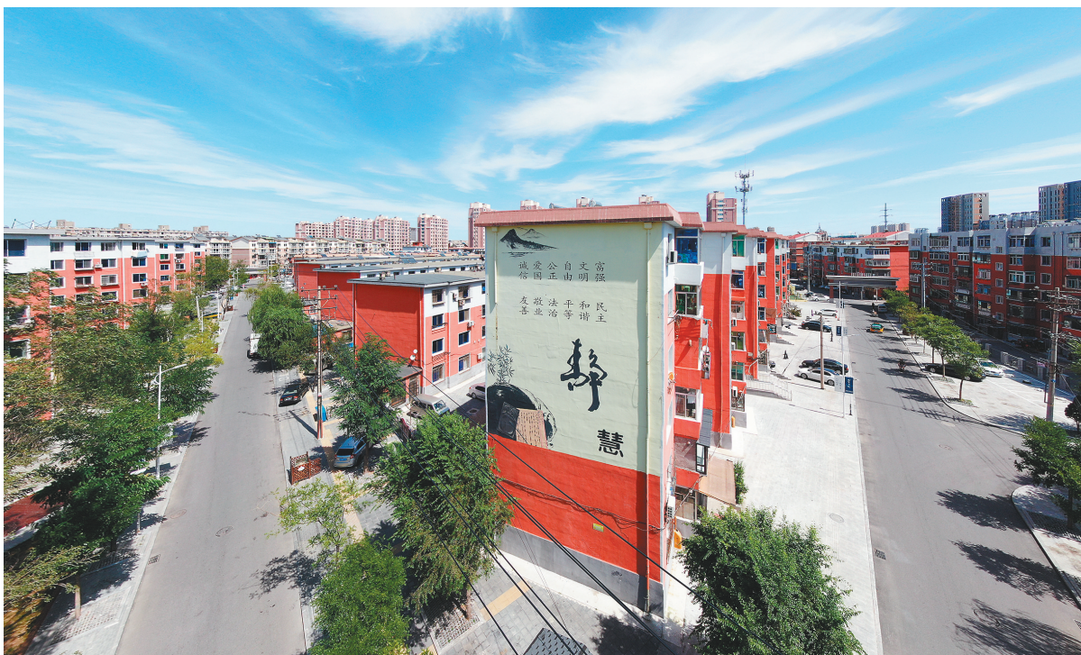
改造后的五大门小区。
