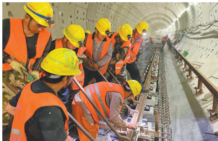
大连地铁五号线施工现场。
