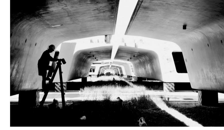
6月14日,工人在郑济高速铁路濮阳至省界段装配式桥梁箱梁预制场工作。近日,由中铁上海工程局承建的郑(州)济(南)高速铁路濮阳至省界段,正加紧进行大范围装配式一体化桥梁架设施工。据介绍,装配式桥梁架设施工工艺是将桥梁墩柱、墩帽、箱梁分别在预制场进行预制,再运到现场组装施工,大幅提高了高铁桥梁的施工效率。
