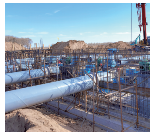
辽水集团柳河生态综合治理项目泵站施工现场。
