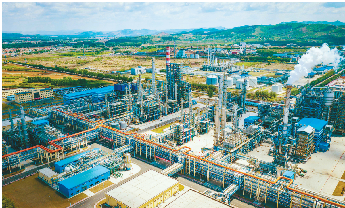
辽阳石化厂区(2021年9月摄,无人机照片)。
