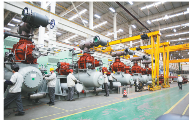
冰山冷热科技股份有限公司生产车间。 陈良琦 摄
