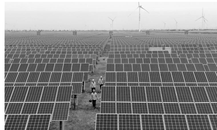
5月14日,在滨州市沾化区富源街道的华能沾化清风光同场项目区,工人们进行光伏电站的日常巡检(无人机照片)。 近年来,山东省滨州市沾化区加快新旧动能转化,大力发展风电、光伏等清洁能源,创新形成“上风、中光、下农”立体绿色低碳产业模式,实现了新能源项目的综合效益最大化。
