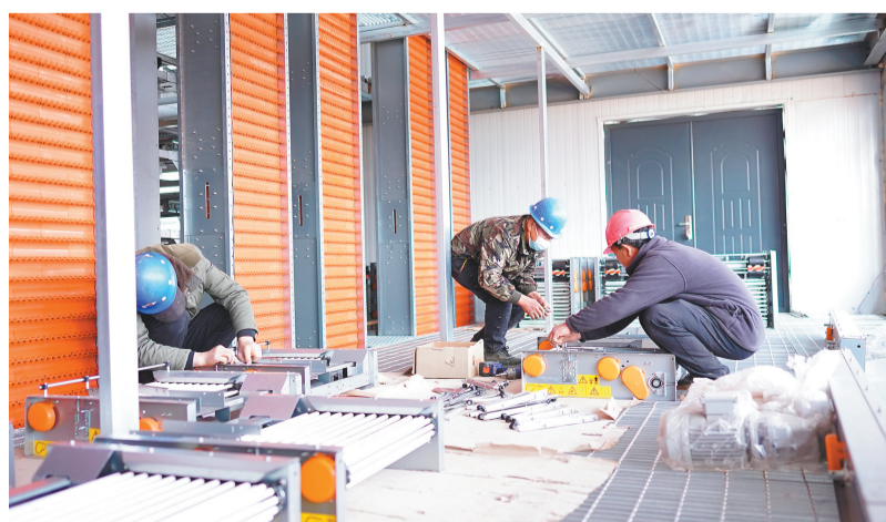
朝阳韩伟蛋业300万只蛋鸡项目设备安装现场。
