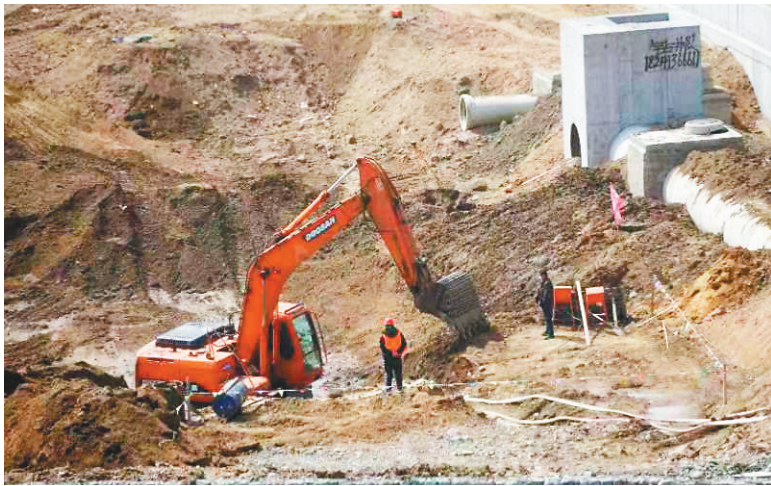
再生资源产业园内正在开展基础设施建设。
