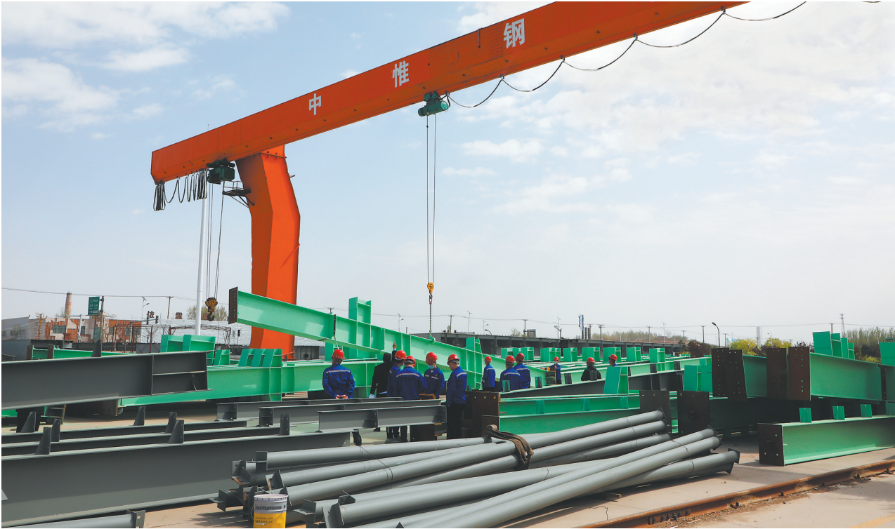
4月26日,辽宁中惟钢结构有限公司年产15万吨新型装配式钢结构项目正式开工。
