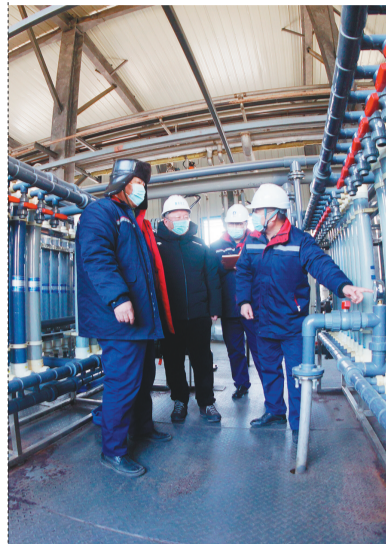
抚顺市鑫龙化工有限公司技术人员正在检修生产设备。
