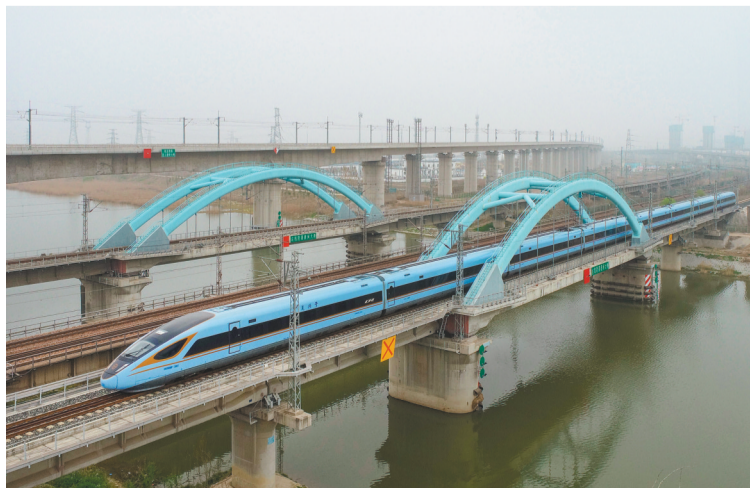
图为一列动车组列车驶过江苏省连云港市海州区境内的一座铁路桥。4月8日零时起,全国铁路实行新的列车运行图。新图统筹考虑铁路新线投用和客货列车开行结构调整,精准配置运力资源,积极服务国民经济平稳运行和高水平对外开放。新华社发
