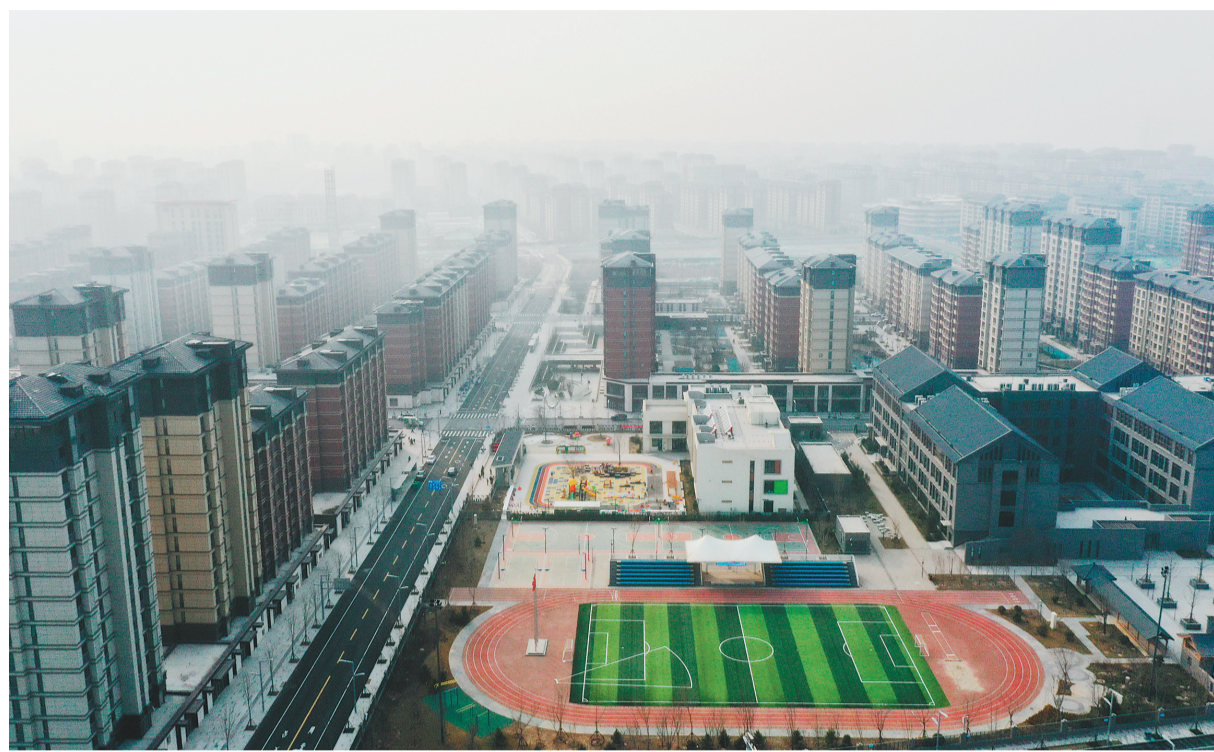
图为雄安新区容东片区(无人机照片)。
