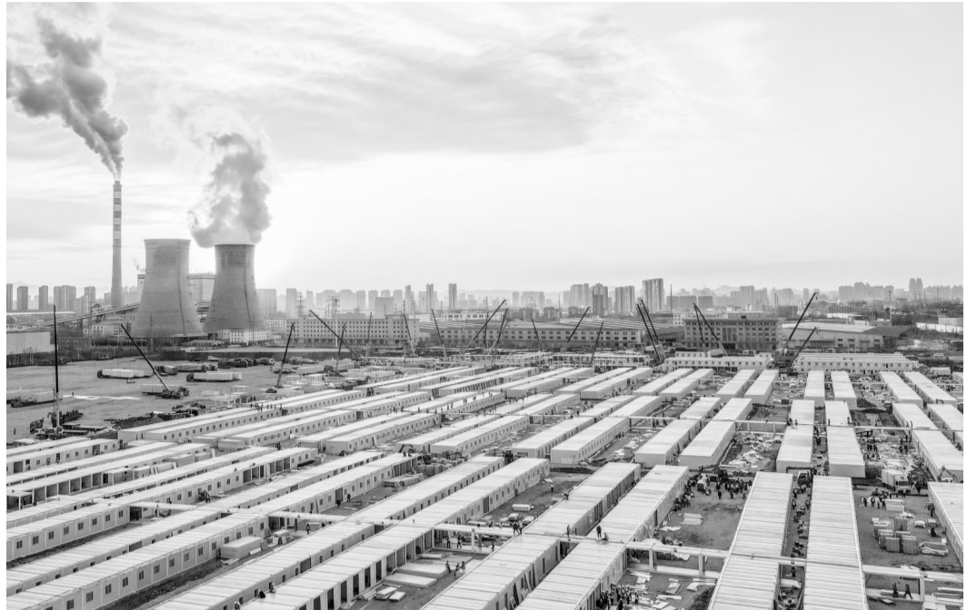
这是3月20日傍晚拍摄的吉林市高新南区隔离方舱建设现场(无人机照片)。 新华社发
