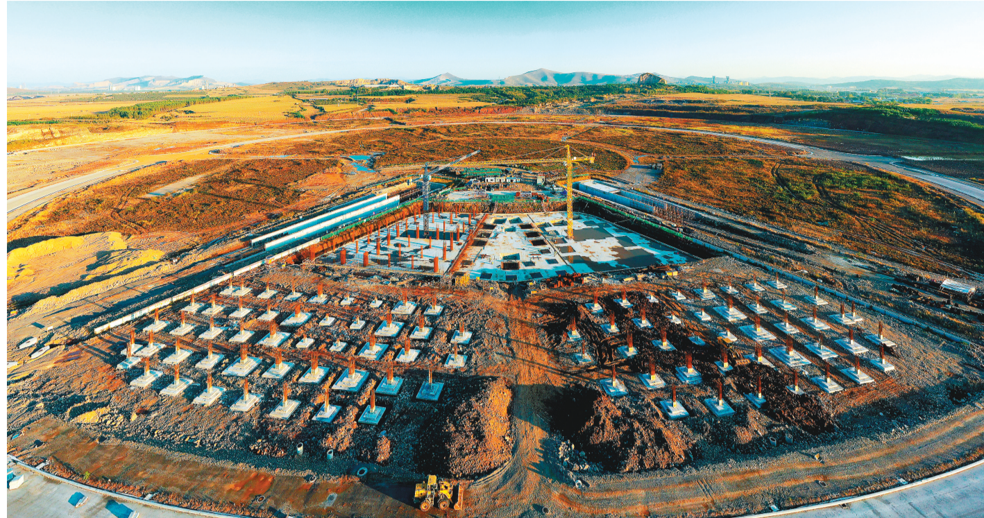
欧洲智能制造产业园项目开工建设。
