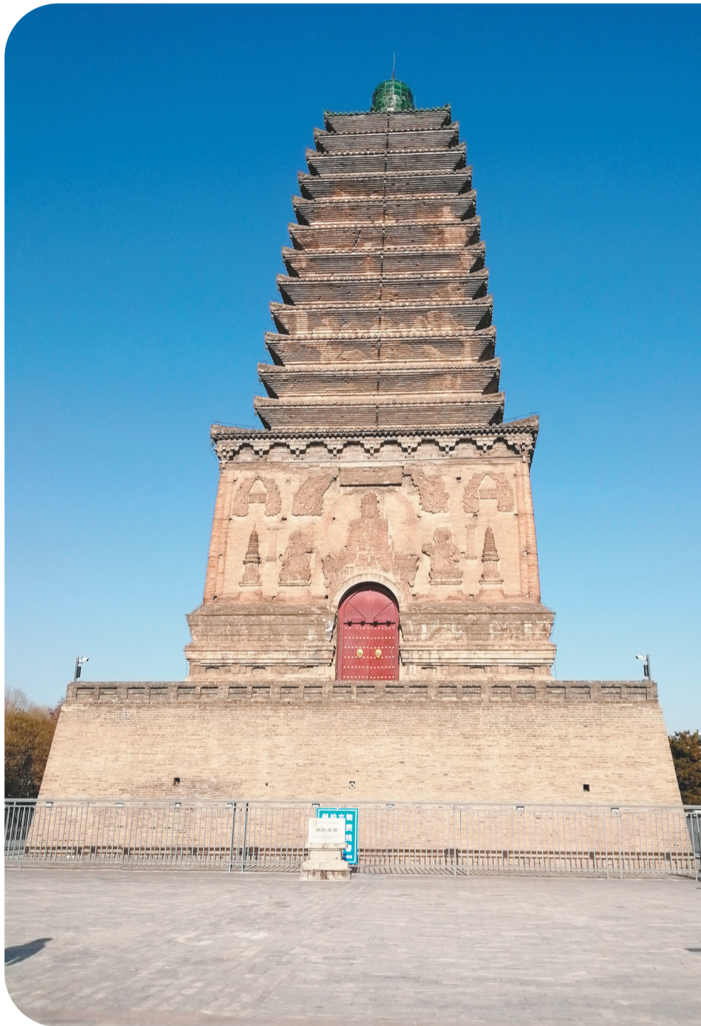
朝阳北塔现貌。
