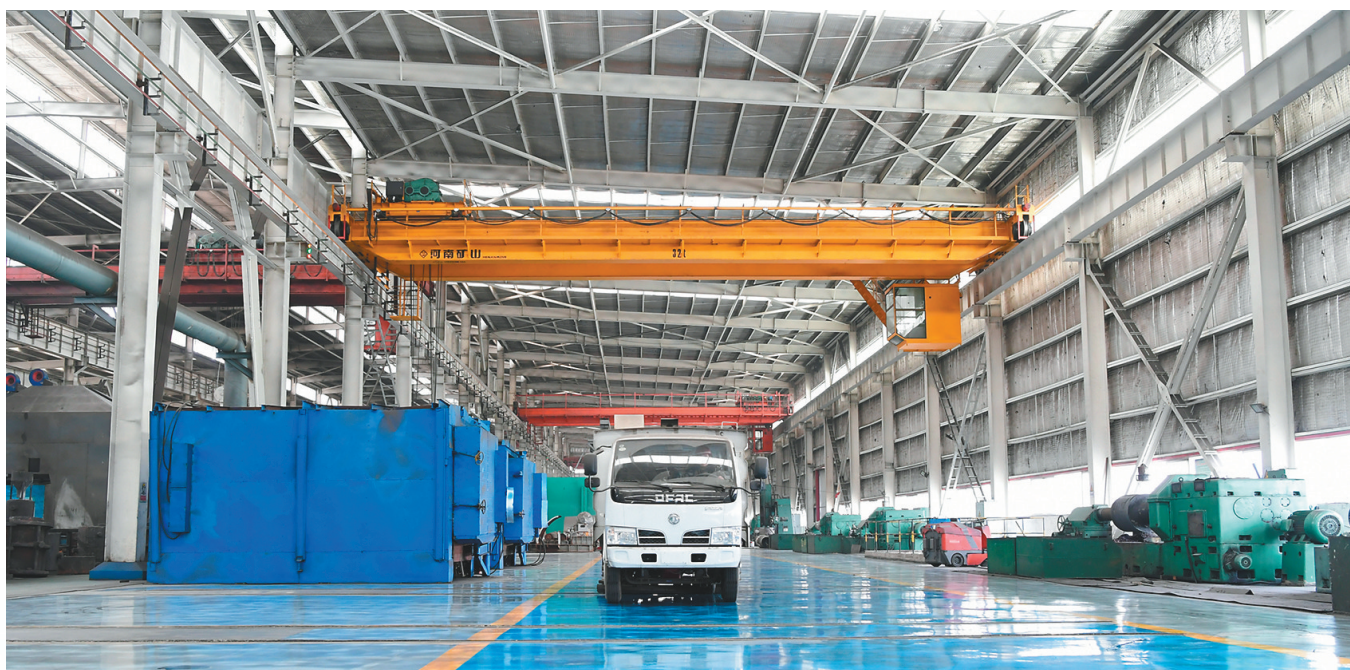
辽宁兆金重型装备制造有限公司生产车间。
