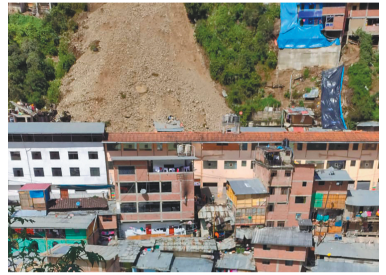
这是3月15日在秘鲁拉利伯塔德大区帕尔科伊县拍摄的山体滑坡现场。秘鲁国家应急指挥中心15日发布消息说,秘鲁北部拉利伯塔德大区当天发生山体滑坡,造成至少15人被困、6人失踪,数十所房屋被掩埋。 新华社发
