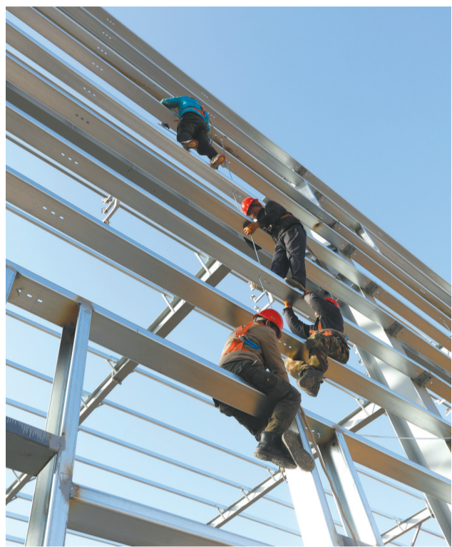
正在建设中的朝阳市宏盛机械制造有限公司环保装备项目。
