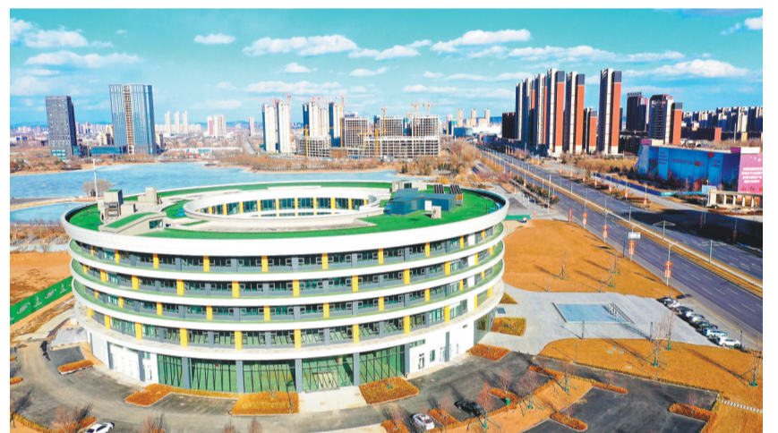
沈抚示范区数字经济产业园C园项目。
