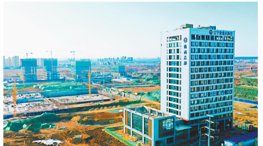
辽宁渝商总部大厦项目。
