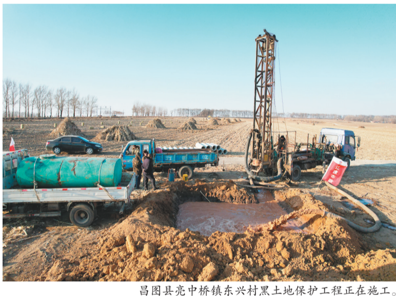
昌图县亮中桥镇东兴村黑土地保护工程正在施工。
