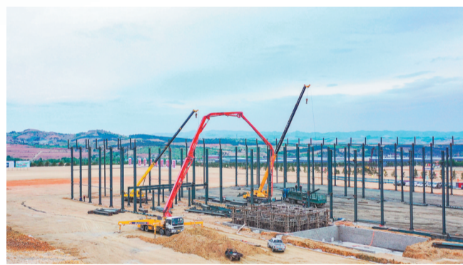
建平县飞地经济产业园项目建设现场。
