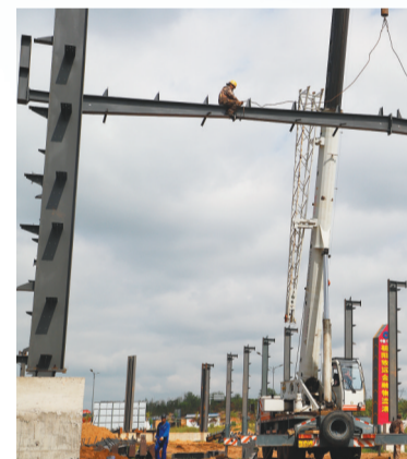
朝阳致远物流港产业园项目建设中。
