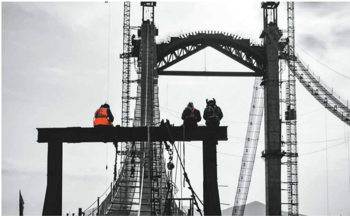
广州街跨小凌河特大桥项目施工现场。
