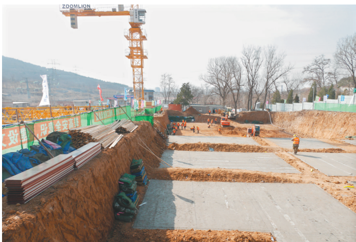
紫荆山脚下的项目建设现场正在进行地基施工。
