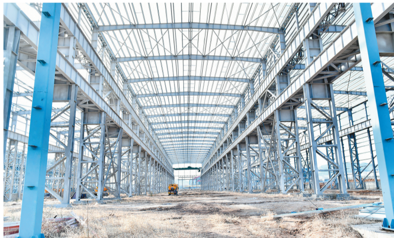
朝阳重型机器有限公司建设高端冶金装备及风电关键部件生产项目。
