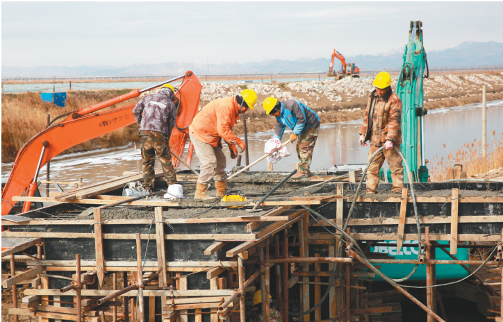
工人正在实施月牙连通河节制闸封顶作业。
