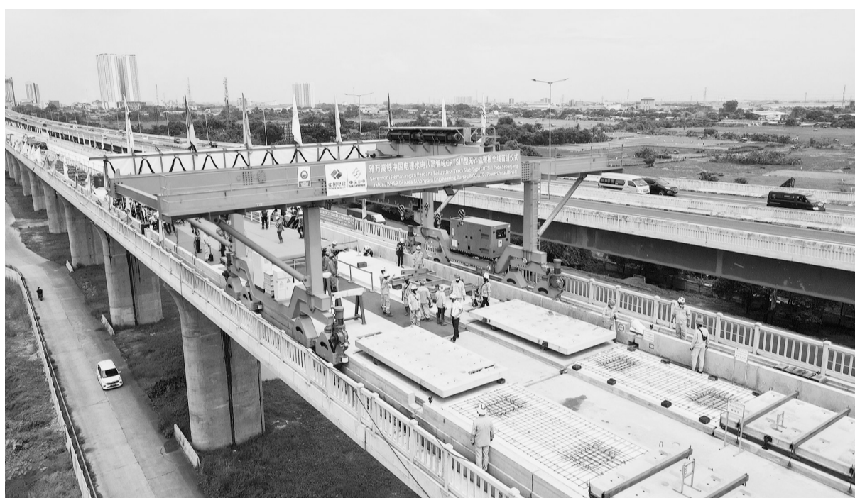
图为12月29日拍摄的印度尼西亚雅加达至万隆高速铁路CRTSⅢ型无砟轨道板首铺施工现场(无人机照片)。印度尼西亚雅加达至万隆高速铁路CRTSⅢ型无砟轨道板首铺仪式29日在2号特大桥DK32举行,标志着雅万高铁工程建设正式进入无砟轨道铺设阶段。
