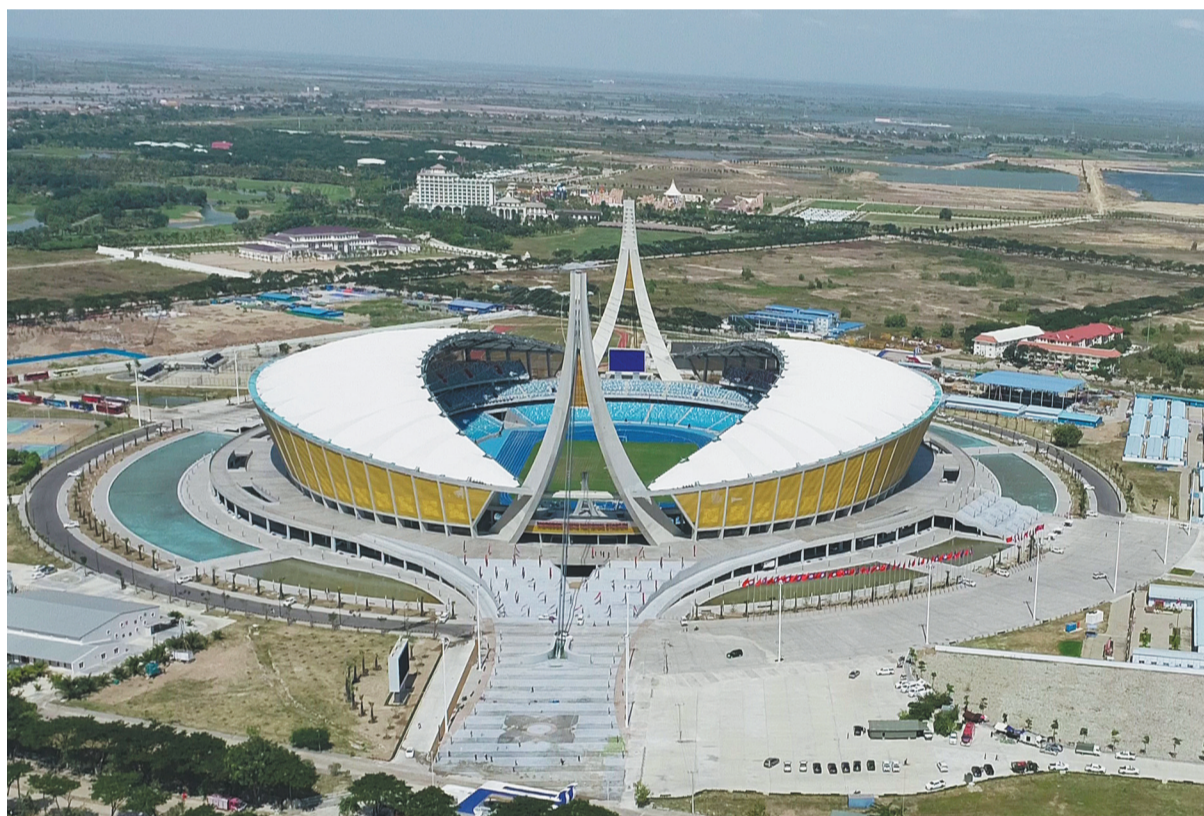
这是12月17日在柬埔寨金边拍摄的中国援建的柬埔寨国家体育场(无人照照片)。由中国政府援建、中国建筑股份有限公司承建的柬埔寨国家体育场项目18日正式启用,柬埔寨首相洪森和中国驻柬埔寨大使王文天出席启用仪式。这里将成为2023年东南亚运动会的主要场馆。
