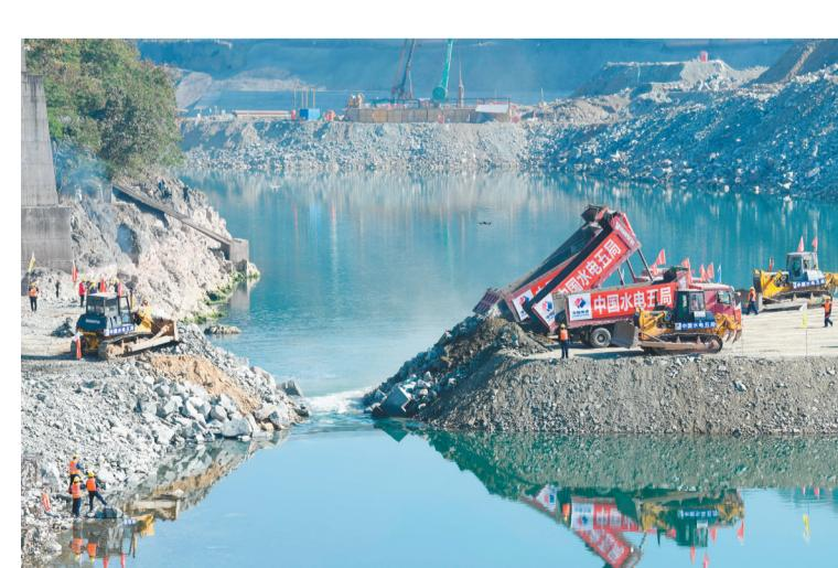
12月16日拍摄的金沙江银江水电站截流施工现场。当日，位于四川省攀枝花市的金沙江银江水电站工程成功实现截流，工程顺利转入主体施工阶段。银江水电站是金沙江中游水电“一库十级”规划的最末一级，建成后将兼具发电、改善城市水域景观和取水条件等功能。
