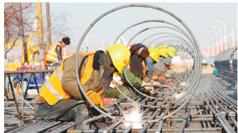
沈抚示范区小沙河生态修复景观工程项目建设现场,工人们正加紧施工。
