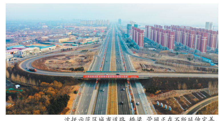
沈抚示范区城市道路、桥梁、管网正在不断延伸完善。
