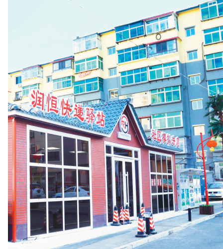
老旧小区改造让老旧小区有了新面貌。
