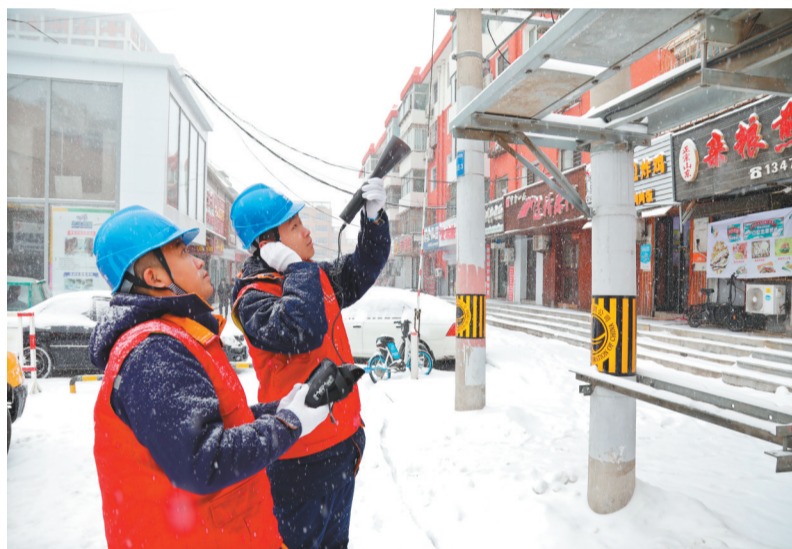
国网阜新供电公司员工顶风冒雪检查设备,确保供电安全。 李京霖 摄
