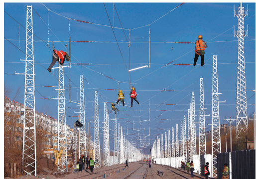
在建设者争分夺秒的奋战下,京沈高铁今年全线通车。
